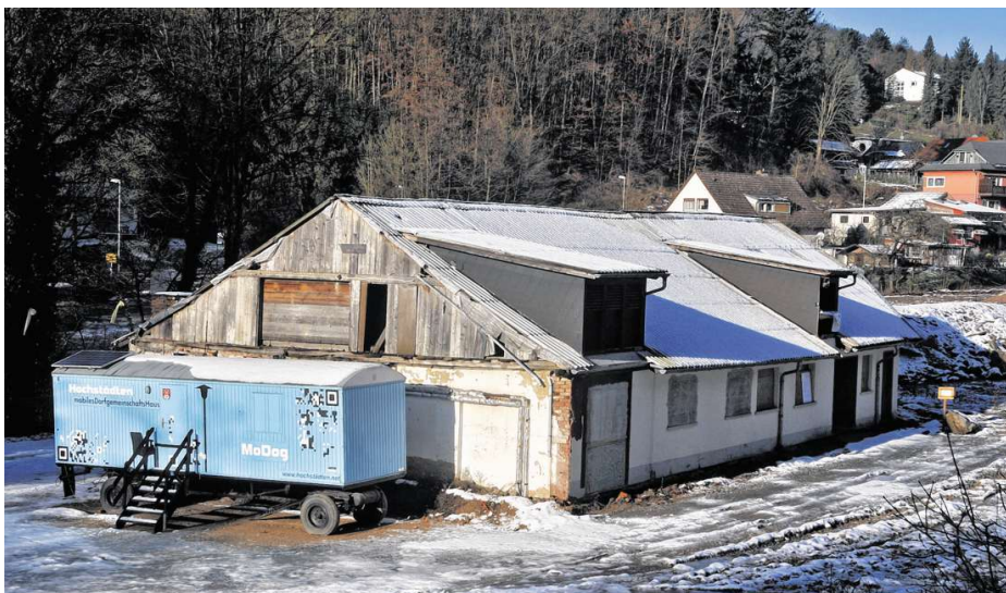
Die alte Kantine des früheren Marmoritwerks soll zum Hochstädter Haus umgebaut werden.
